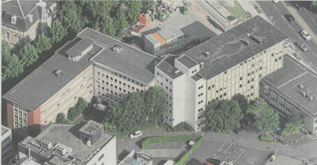
Als Finanzamt und Kreishaus entstanden in den 1950ern die Bürogebäude in der Stadtmitte. Heute sind sie marode.
