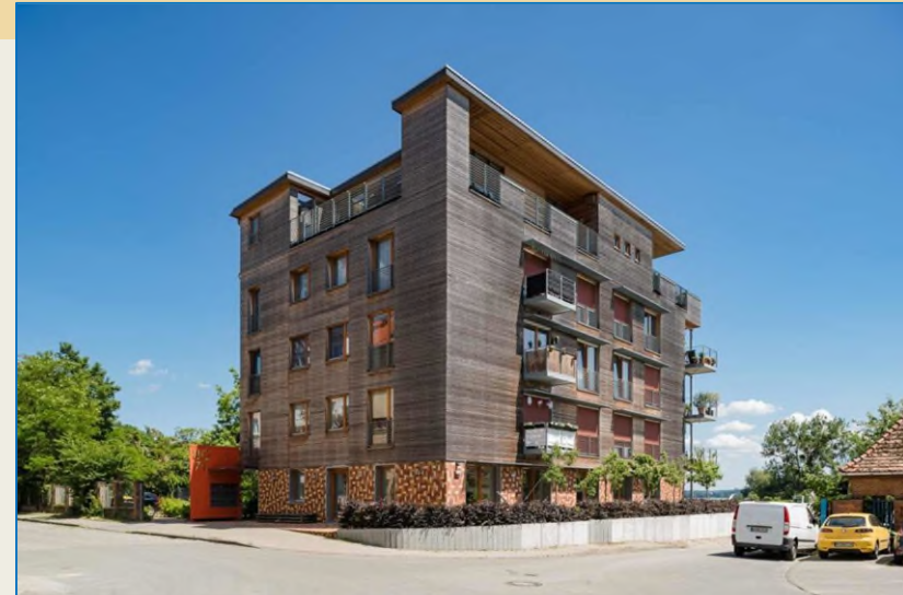
Schwerin, zu Mehrgenerationenhaus umgenutztes und umgebautes ehemaliges Verwaltungsgebäude aus den 1970ern, 2021
