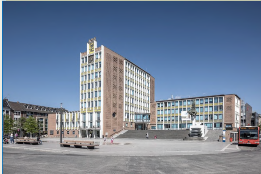
Düren, saniertes Rathaus aus der Nachkriegszeit
