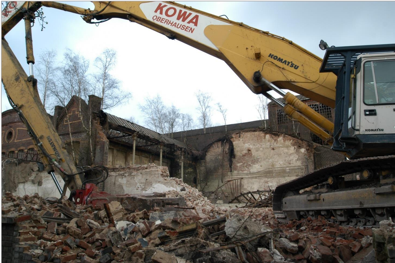
Abriss der Zeche Rheinpreußen I, Duisburg, 2007 (Foto: Gelhar 2006)
