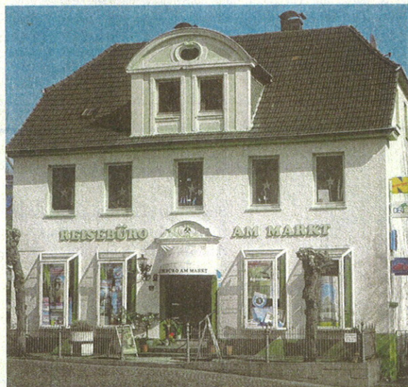
Für das frühere Verwaltungsgebäude der Erzgrube Berzelius am Marktplatz in Bensberg liegt ein Abrissantrag vor. Foto: privat
