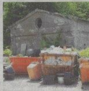
Aus Beton ist das Gebäude, in dem die Fördermaschine stand.
