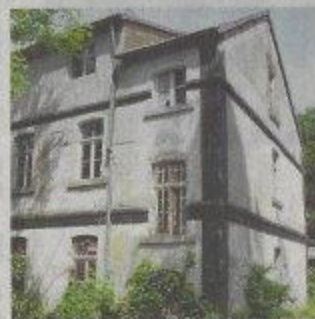
Das ehemalige Verwaltungsgebäude der Grube Weiß heute.
