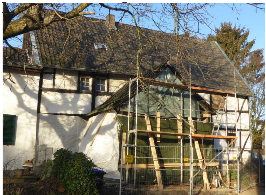
Sanierungsbeginn am Rommerscheider Hof (Foto 16.2.2019).
