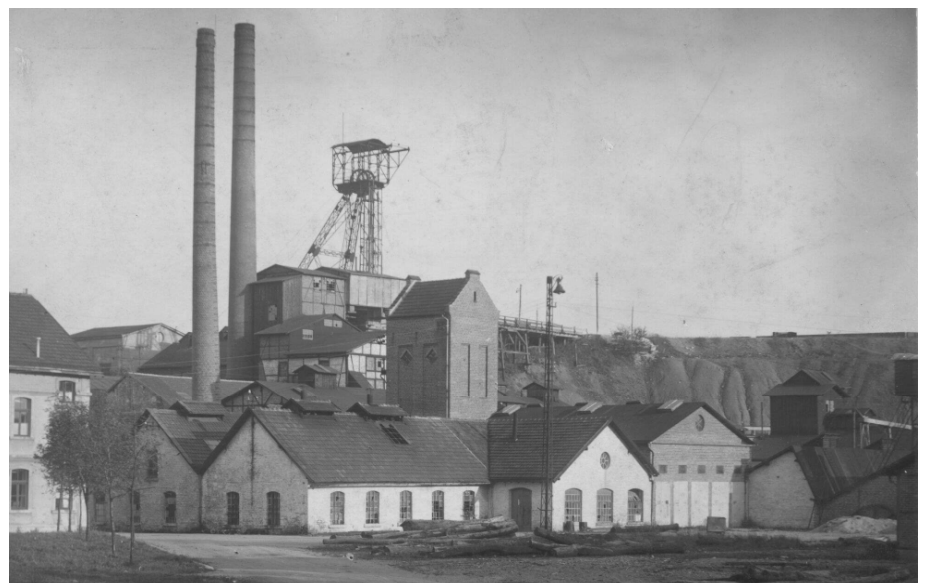
Grube Weiß um 1917. Links Teil des Verwaltungsgebäudes, da drüber im Hintergrund Maschinenhaus aus Stahlbeton und Bildmitte Trafoturmschacht mit nach vorne hin vorgelagertem Transformatorenhaus (StAGL D 1622/2).
