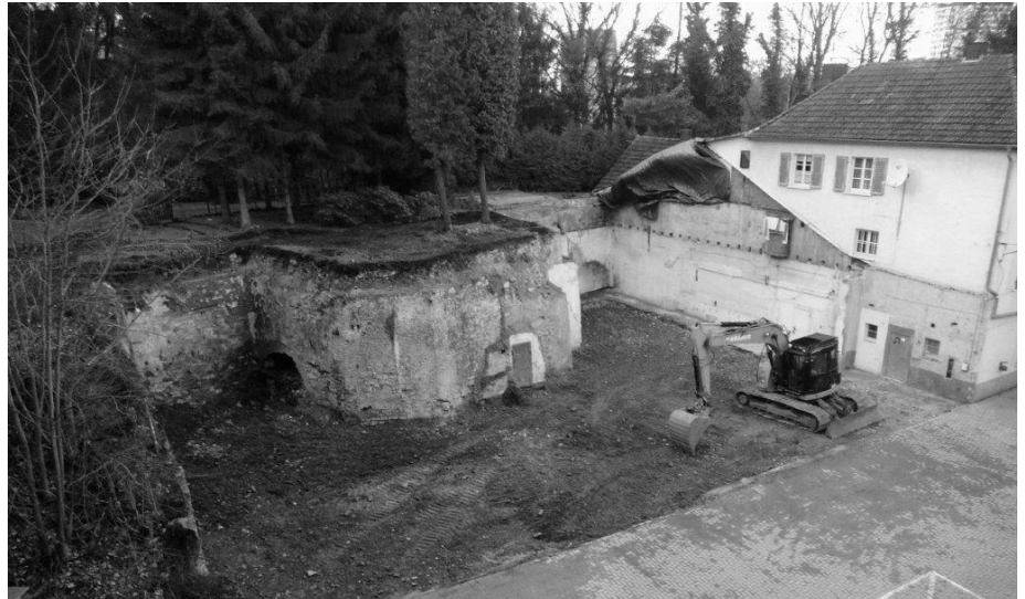
Freigestellte Kalköfen am Quirlsberg (Foto H. Cramer 13.12.2013).
