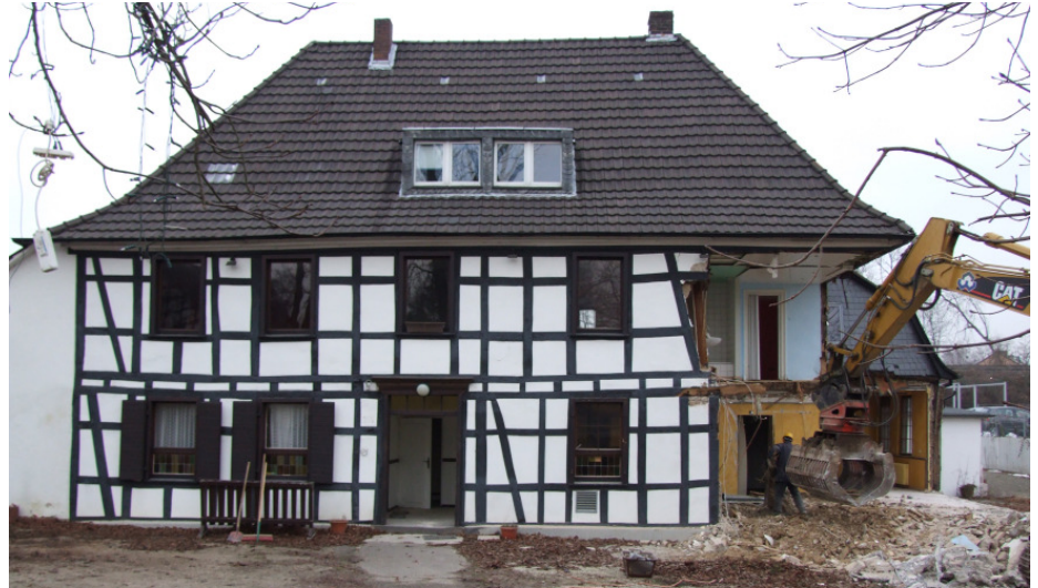
Abbruch von Haus Kradepohl (Foto N. Stannek 16.1.2009).
