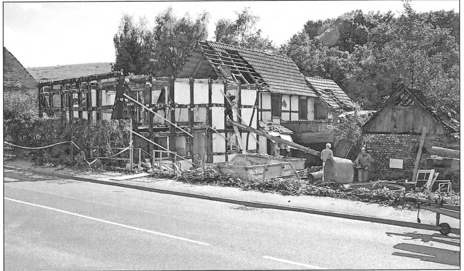
Demontage des Fachwerkhouses Romaneyer Str. 34 (Foto: T. Klostermann, 24.9.2007)
