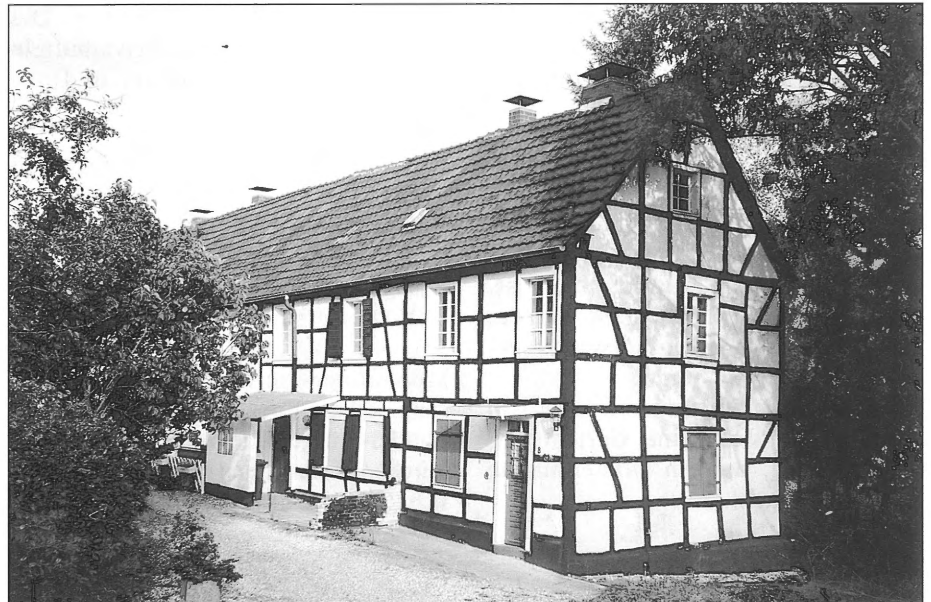
Fachwerkhausensemble „An der Kirche“ in Bensberg. Das Gebäude wurde 2004 abgerissen und durch einen Neubau ersetzt.
