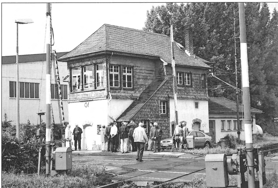
Beim Aktionstag „Denkmal des Monats“ hatten Interessierte am 27.6.2006 Gelegenheit, im Stellwerk an der Tannenbergsstraße die mechanische Technik von 1911 zu besichtigen. (Foto: Manfred Dasbach)
