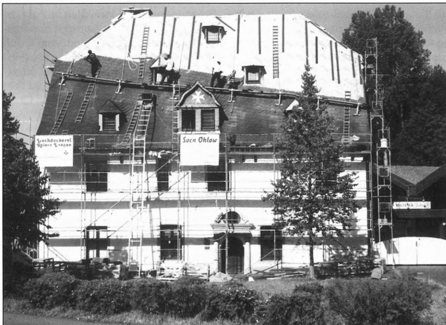
Das Dach der Malteserkomturei wird saniert (Foto: T. Klostermann, 1.8.2005).
