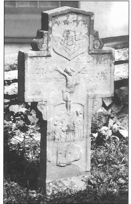
Gleiches Kreuz nach der Sanierung (Foto: T. Klostermann, 6.9.2005)
