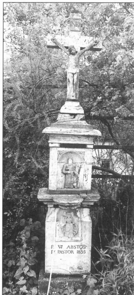
Das einsturzgefährdete Wegekreuz von 1835 neben dem Haus Straßen 80, Ecke Ball (Foto: St. Gloßner, 6.5.2005)
