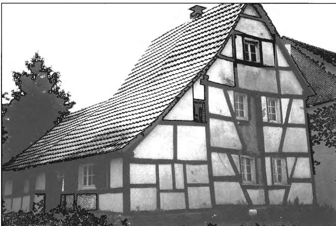
Vorderansicht vor dem Abbruch (Foto Broich, 13.5.99)
