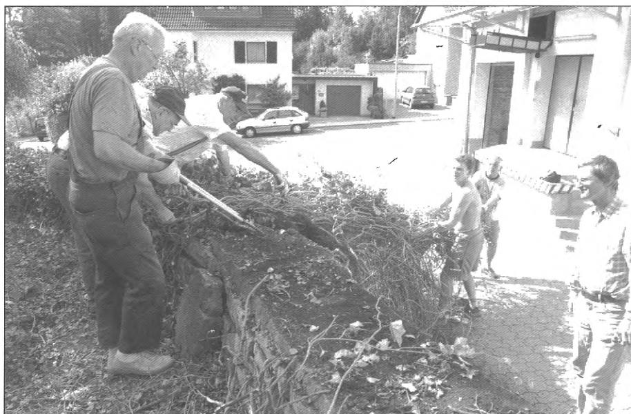
Sander Bürger befreien die alte Bruchsteinmauer von Sämlingsbäumen und Efeu (Foto: Ch. Arlinghaus, 26.8.03).
