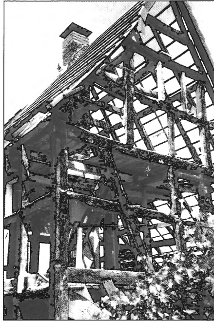
Entkernte Fachwerkkonstruktion bei der Demontage (Foto Broich, 21.6.2003)
