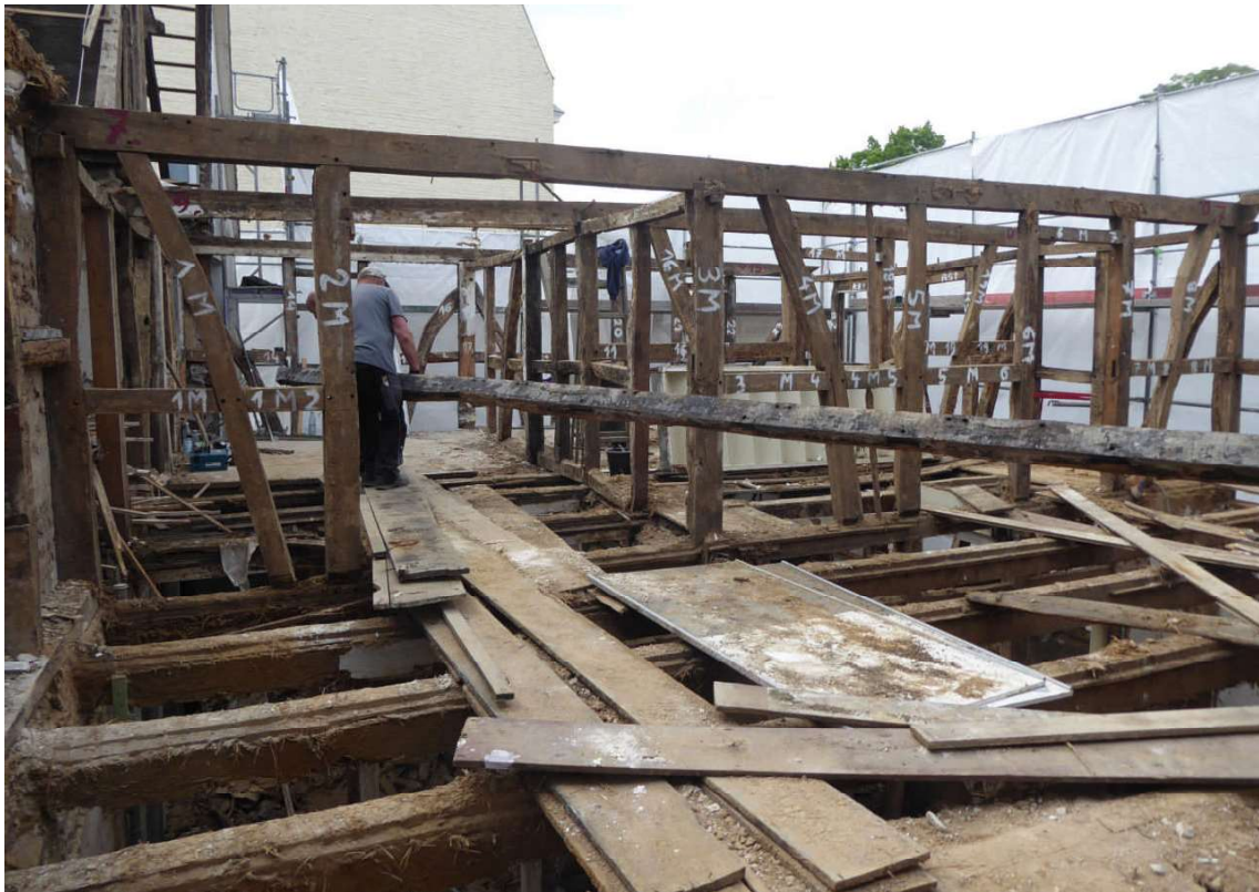
Das Obergeschoss des westlichen Teils des Fachwerkhäuses
