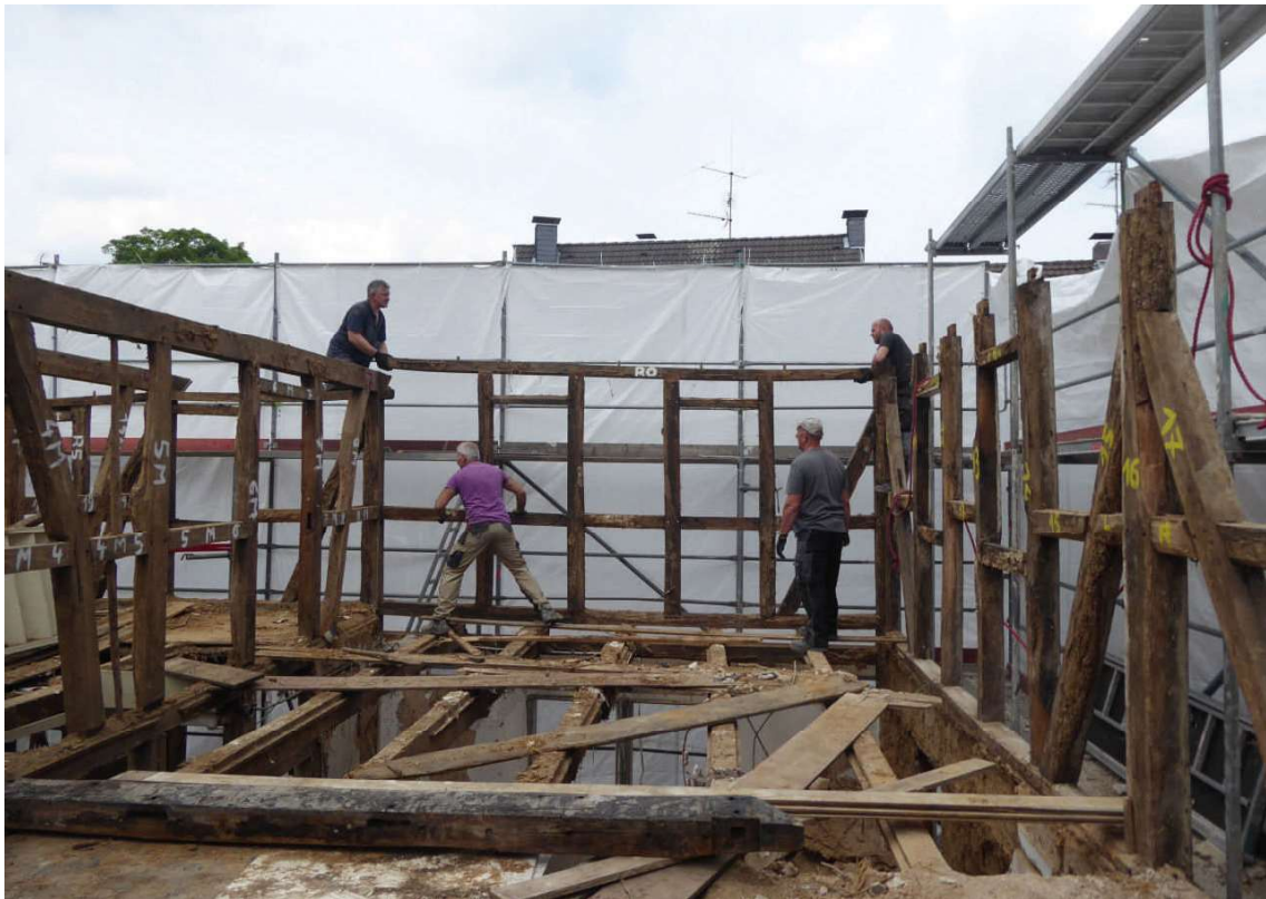
Obergeschoss des Anbaus (Blickrichtung Straße). Links die ursprüngliche Außenwand des Baus von 1824.
