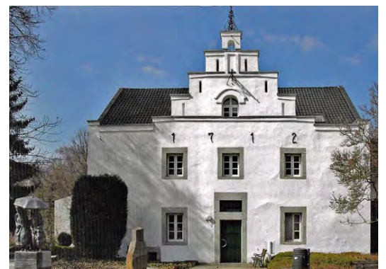
Wasserturm in Velbert aus dem Jahr 1904 (links). Sonderheft, S. 52
